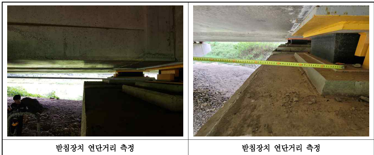
【사진 18.3.42】 교량받침장치 연단거리측정
