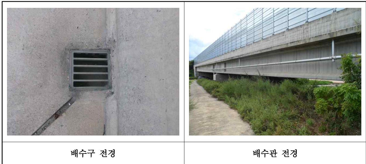
【사진 18.3.22】 배수시설 전경
