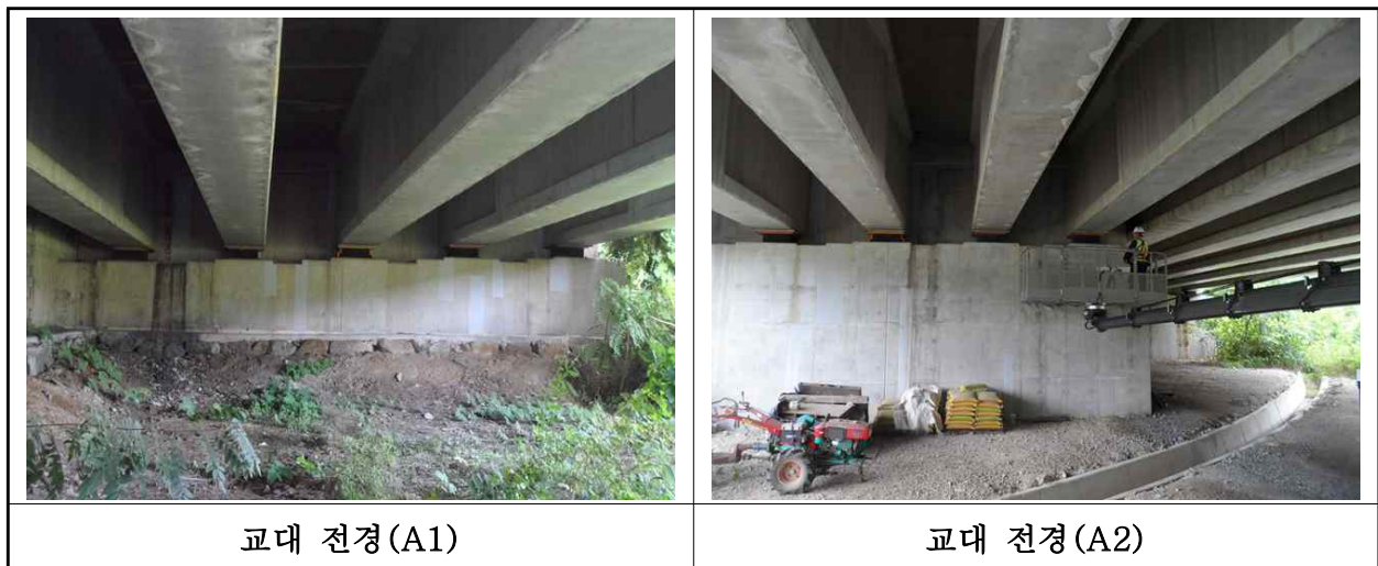
【사진 18.3.8】 교대 전경
