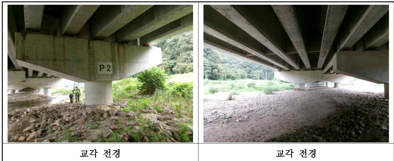
【사진 18.3.37】 교각 전경
