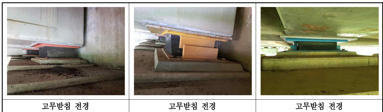
【사진 18.3.40】 교량받침 전경
