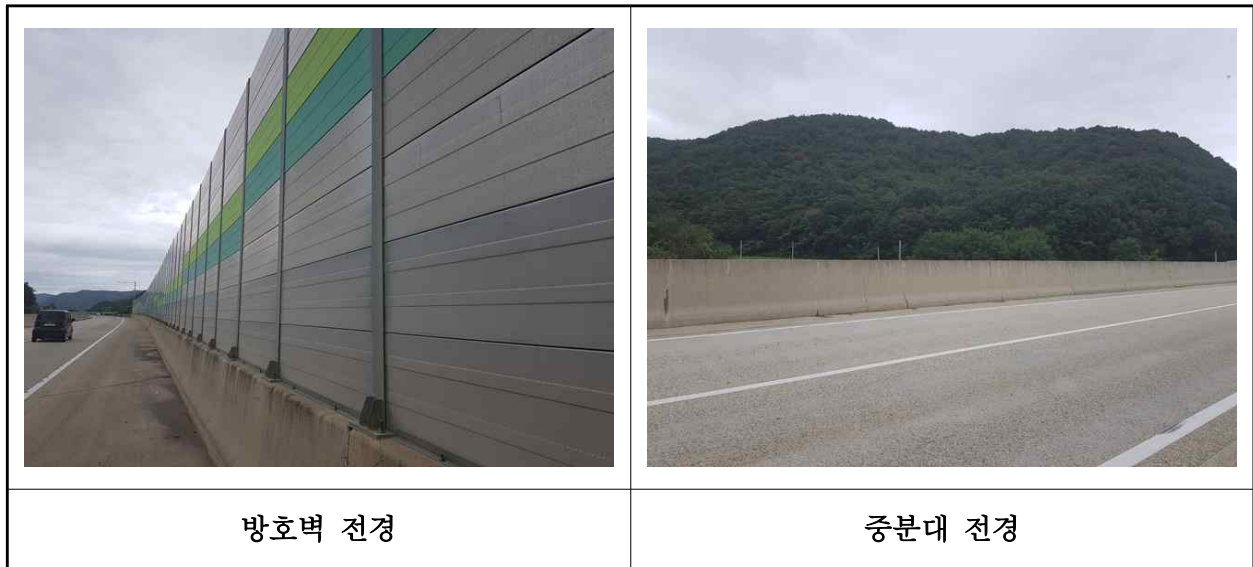
【사진 18.3.24】 방호벽 및 중앙분리대 전경
