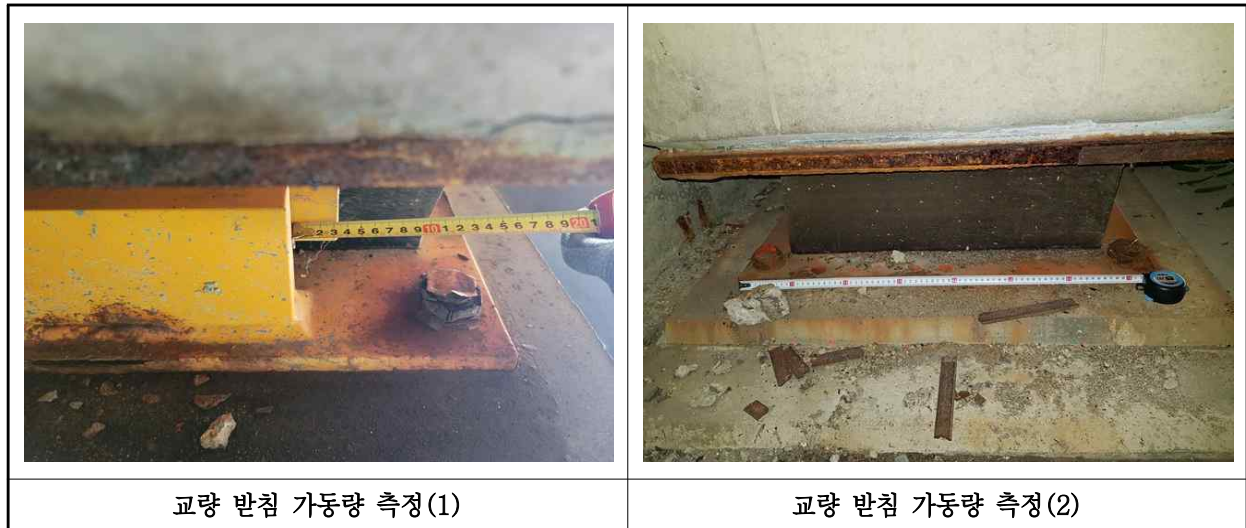
【사진 18.3.16】 교량받침 이동량 측정
