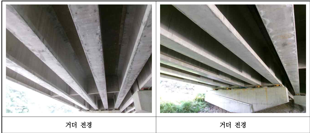
【사진 18.3.31】 거더 전경
