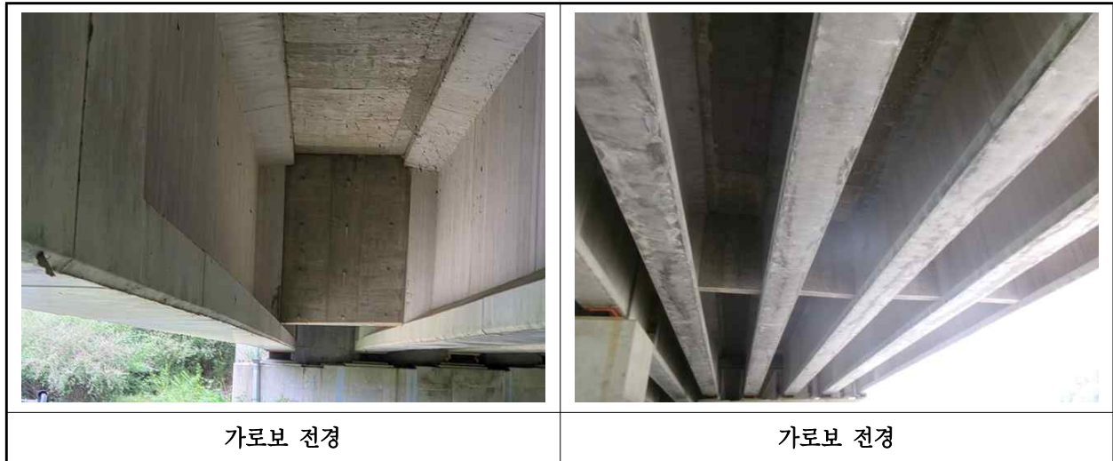
【사진 18.3.33】 가로보 전경
