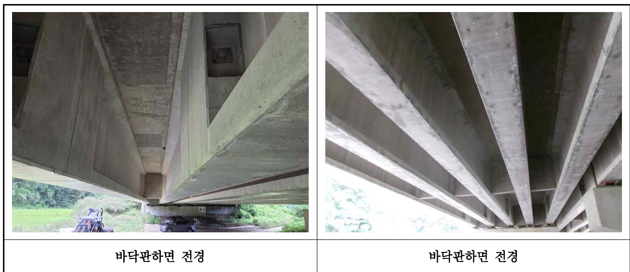
【사진 18.3.29】 바닥판하면 전경
