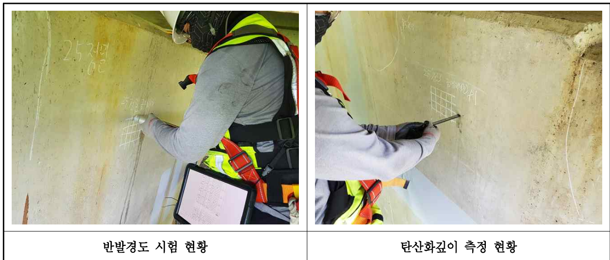
【사진 18.4.1】 콘크리트 내구성조사 현황
