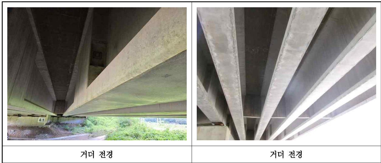
【사진 18.3.4】 거더 전경
