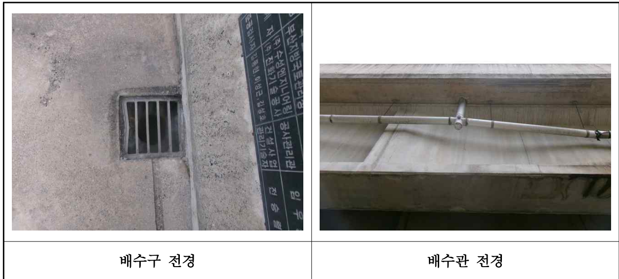
【사진 18.3.49】 배수시설 전경
