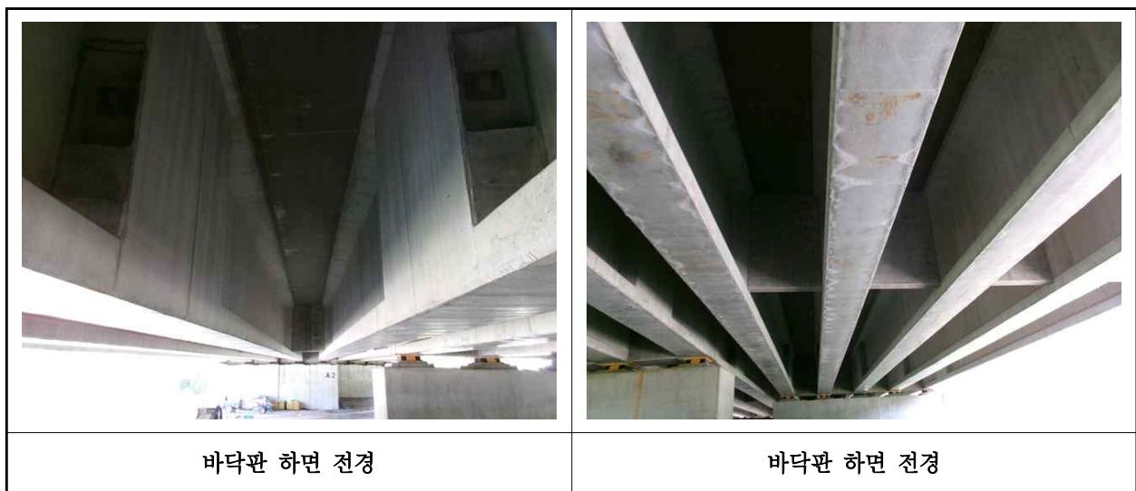
【사진 18.3.2】 바닥판하면 전경
