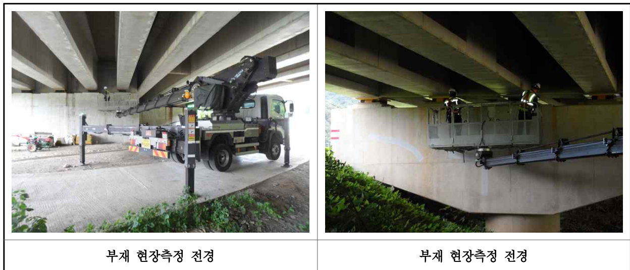
【사진 18.2.1】 부재 현장측정 전경
