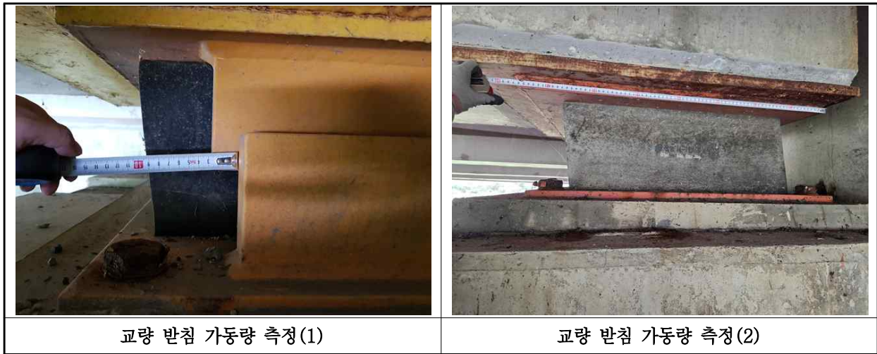
【사진 18.3.43】 교량받침 이동량 측정
