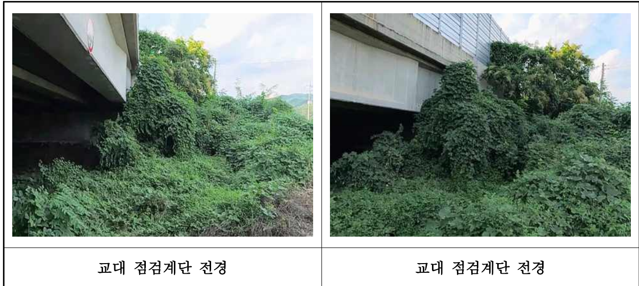
【사진 18.3.26】 교량 점검시설 전경
