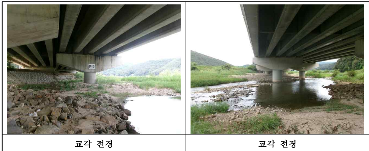
【사진 18.3.10】 교각 전경
