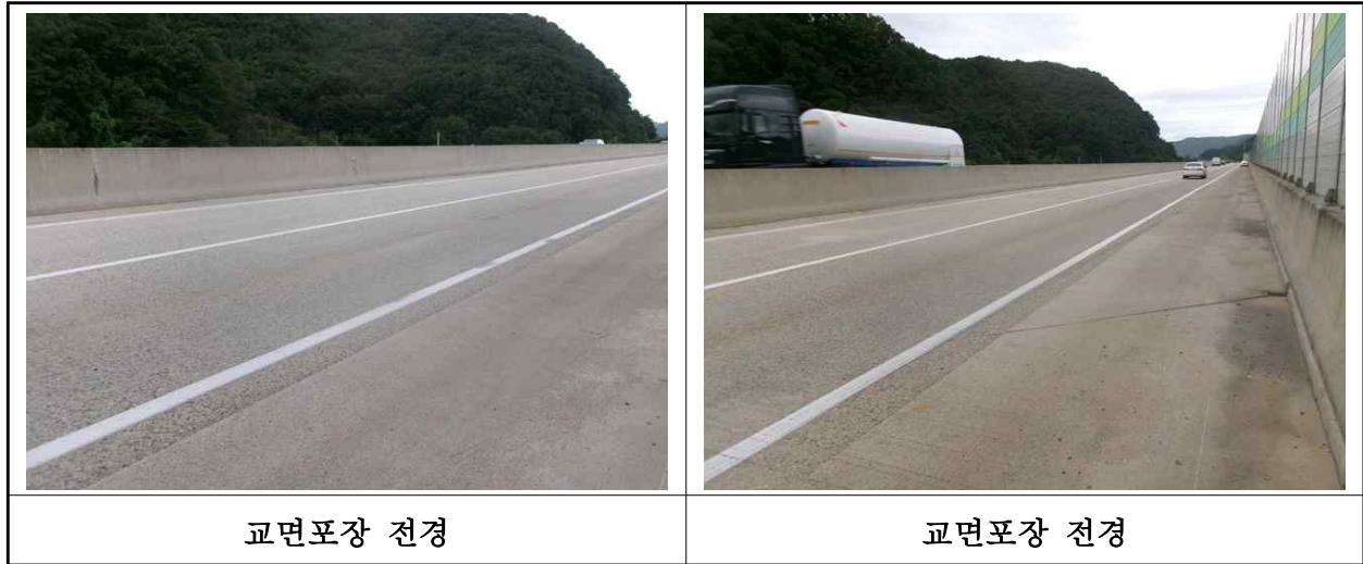
【사진 18.3.20】 교면포장 전경
