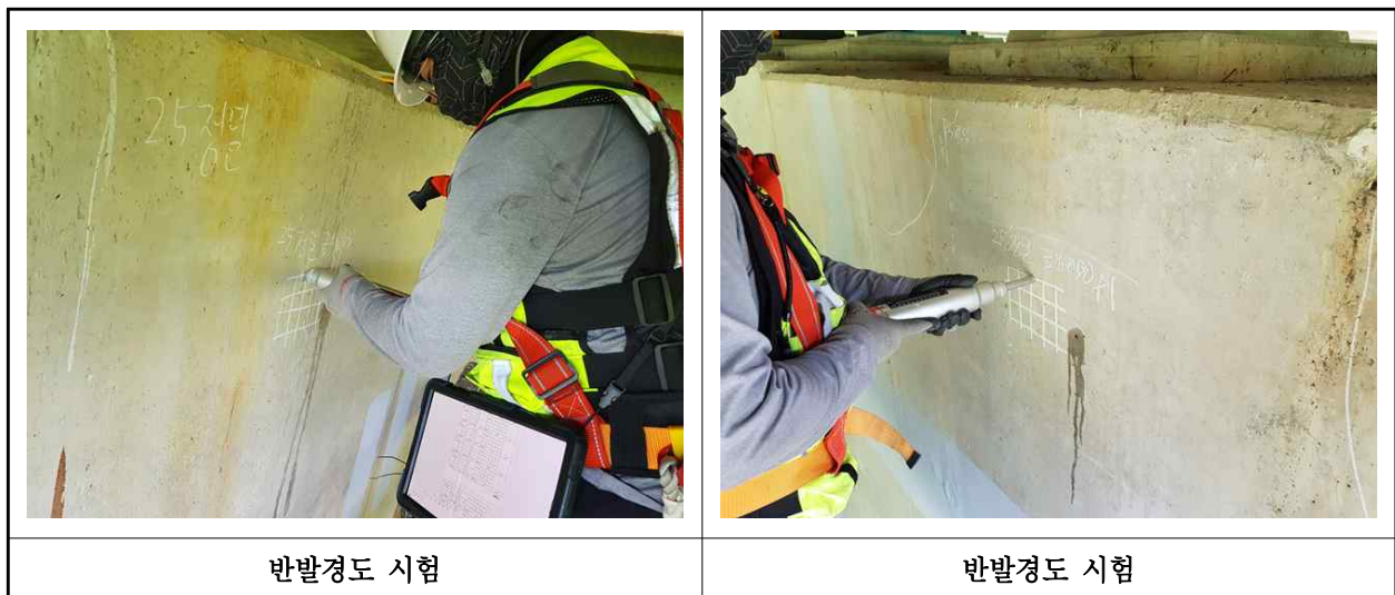
【사진 18.4.2】 반발경도시험 현장사진
