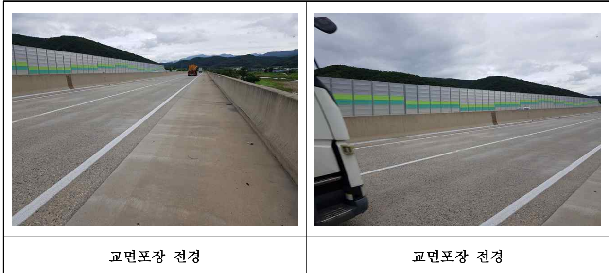
【사진 18.3.47】 교면포장 전경
