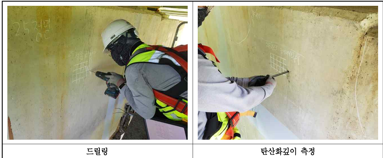
【사진 18.4.3】 탄산화 깊이 측정 현장사진
