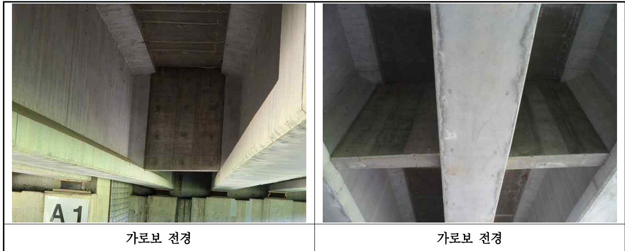
【사진 18.3.6】 가로보 전경
