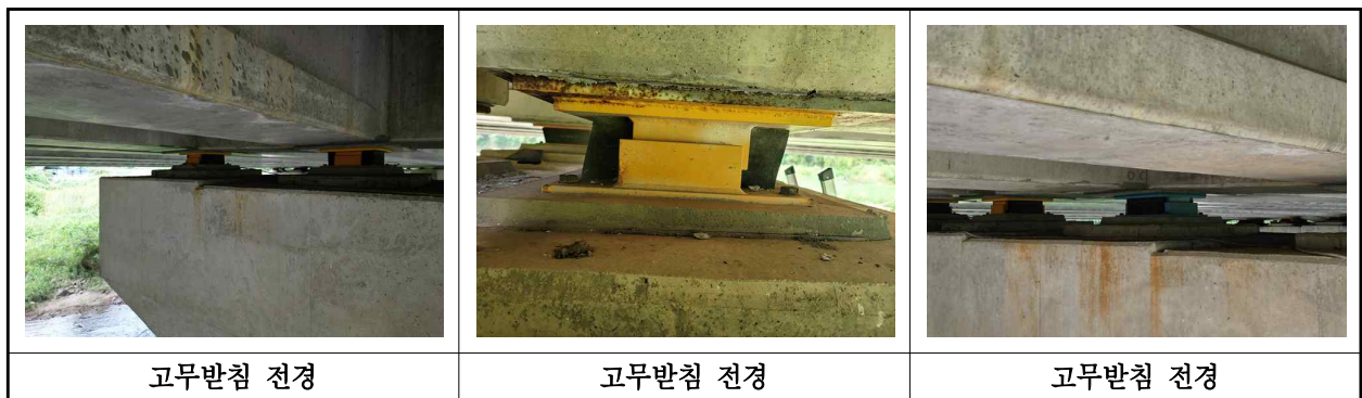
【사진 18.3.13】 교량받침 전경
